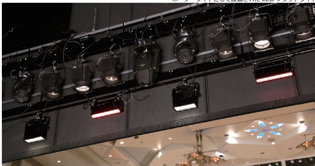
ボーダーライトとして設備されたLED フラッドライト
