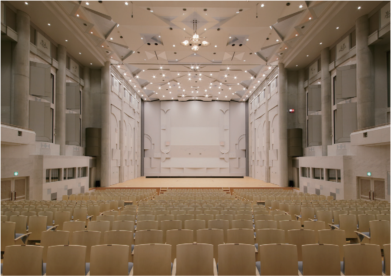
音響反射板を設置した舞台
