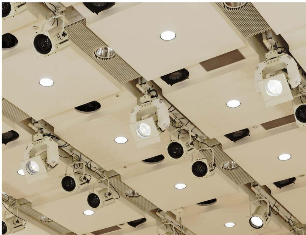
舞台、客席上部のライトバトンには、リモートコントロールスポットライトが設備されています。シューティング機能付調光操作卓による制御によって、仕込み時間の短縮化、安全で迅速な明かりづくりが実現されます。
