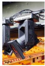
バルコニーなど客席の中に設備されているリモートコントロールスポットライトは、劇場空間の雰囲気を大切にするために動作精度の高さと共に静音性が追求されています。
