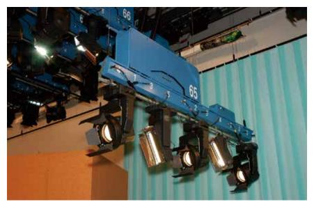
レギュラー化した生放送番組や各種情報番組の制作を中心に、1日に複数の番組制作がおこなわれるスタジオでは、照明仕込み作業の時間をさらに短縮できるように1点吊りバトンを採用。さらにリモートコントロールスポットライトとベース明かりをつくる新開発のリモートコントロールフラッドライトを設置し、仕込み作業の自動化がはかられています。
