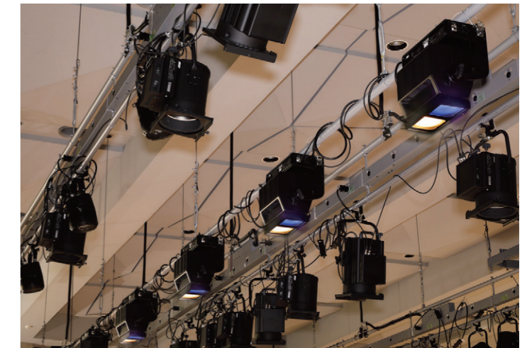
第2ボーダーライトに設備されたLEDフラッドライト(LBC-WB)
