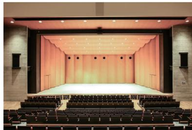
音響反射板を設置した舞台
