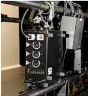
MCDの性能をフルに引き出す20A 3回路のC-60プラグ仕様と、既存の設備で使いやすい最大負荷30AまでのC-30プラグ仕様の2つのラインナップです。
